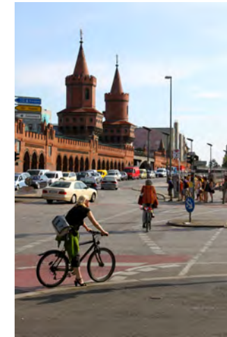
Oberbaumbrücke/Warschauer Straße Berlin, Germany
